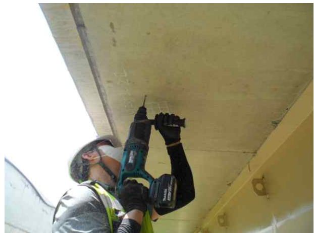
탄산화깊이 측정 현황
