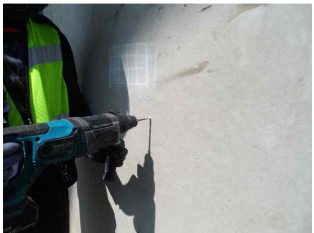
탄산화깊이 측정 현황
